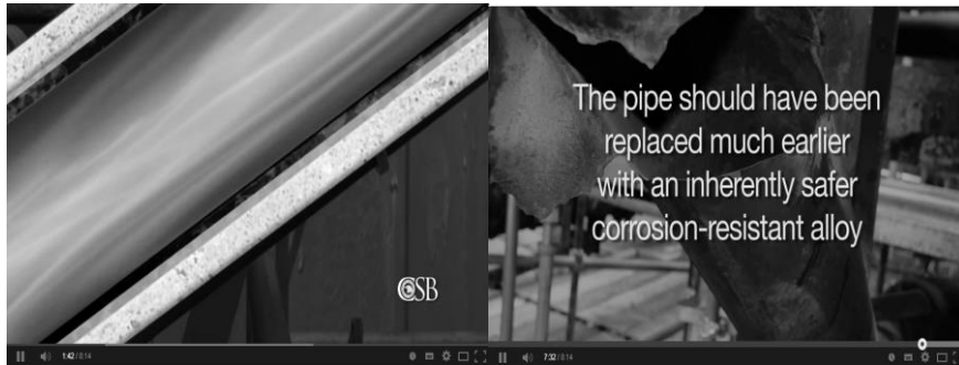
Fig. 3. Daño por corrosión de una tubería de proceso de la refinería de Richmond. Fuente: http://www.youtube.com/watch?v=QiILbGbk8Qk
